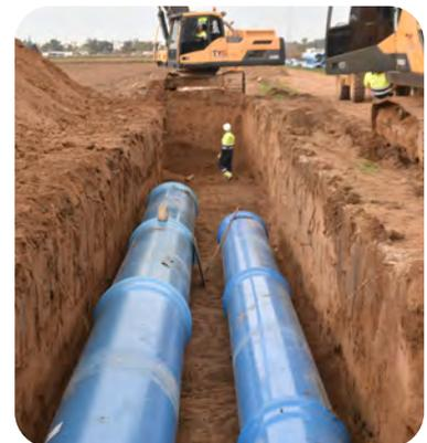
Imagen 7: Zanja tipo para el soterrado de las conducciones en parcela
