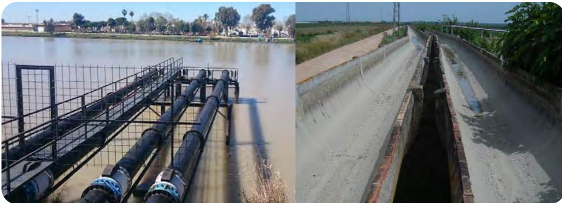
Imagen 4: Estación de bombeo de captación desde el río Guadalquivir y tramo inicial de doble trazado de la red principal de acequias
