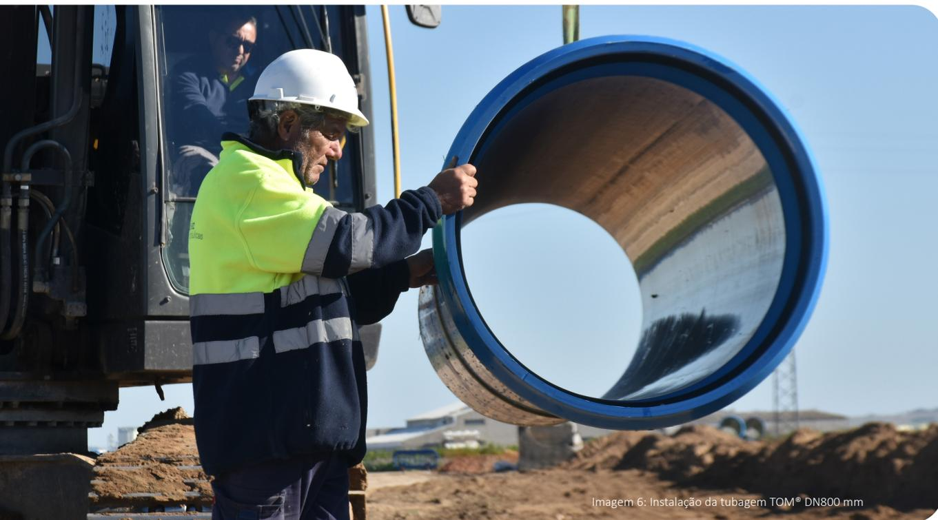
Imagem 6: Instalação da tubagem TOM® DN800 mm
