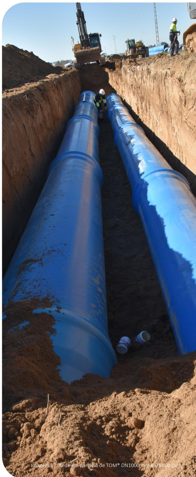
Imagem 17: Rede em paralelo de TOM® DN1000 mm e DN800 mm
