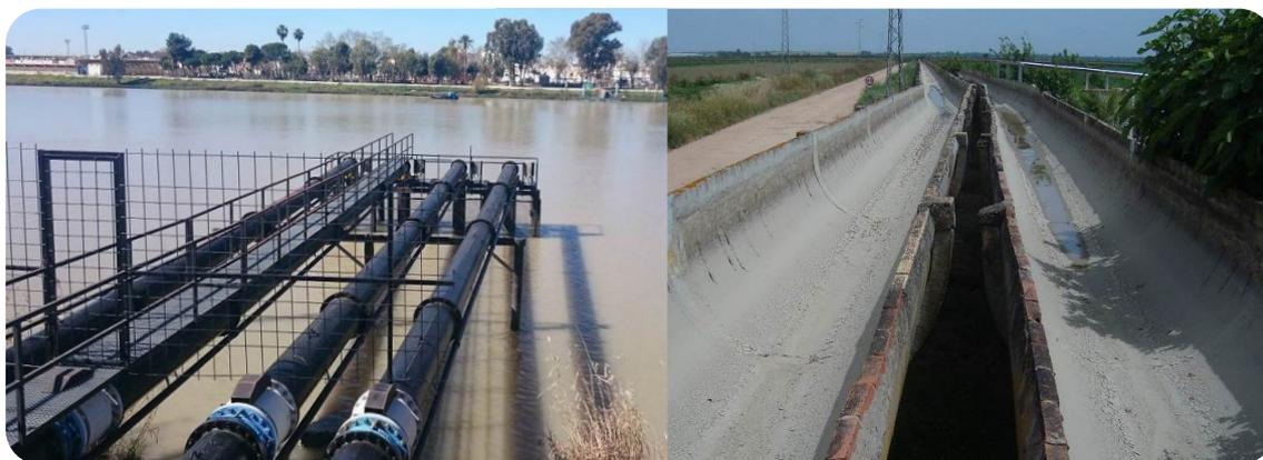
Imagem 4: Estação de bombeamento de captação desde o rio Guadalquivir e troço inicial de duplo traçado da rede principal de acéguas
