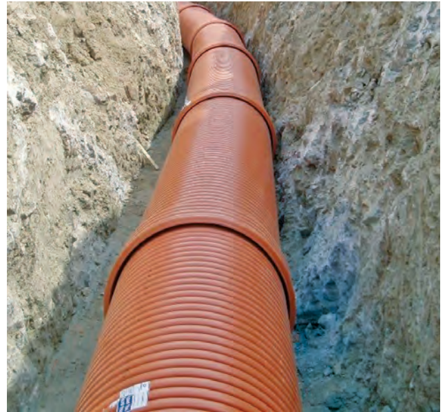
TUYAUTERIE SANECOR® DE 1200 MM AVEC DÉVIATION ANGULAIRE
