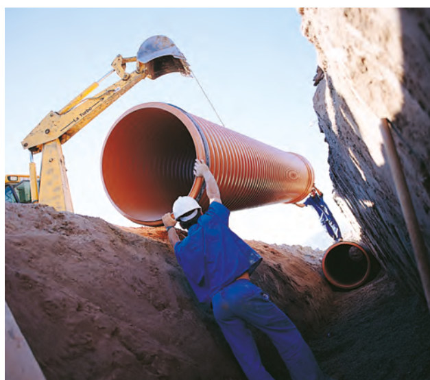
INSTALLATION DE TUBES SANECOR® EN GALERIE ET EN FOSSÉ
