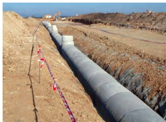
COLLECTEUR EN BÉTON ARMÉ
