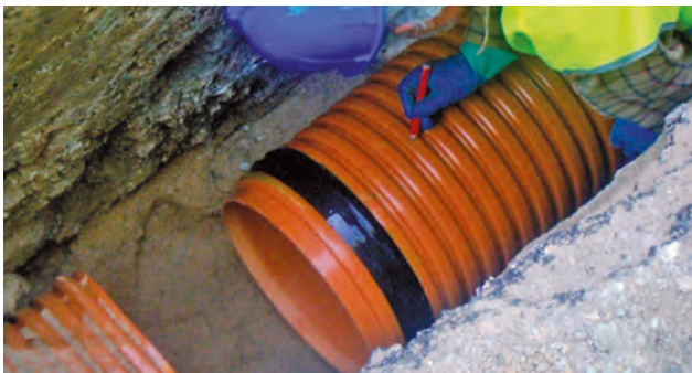
CONNEXION MANUELLE DE TUBES ANNELÉS
