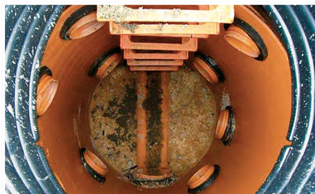
RÉALISATION DE MULTIPLES BRANCHEMENTS RÉALISÉS IN SITU
