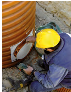
PROCÉDURE DE PERFORATION DE TROUS POUR INSERTION DE CLIPS EN ÉLASTOMÈRE
