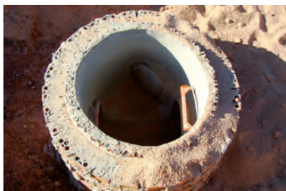
REGARDS EN MATÉRIAUX CONVENTIONNELLS (BÉTON ET BRIQUE) À DROITE, ANNEAUX PRÉFABRIQUÉS EN BÉTON
