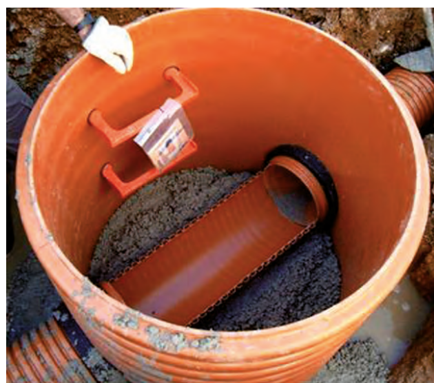
BÉTONNAGE DU FOND DU REGARD - 2ÈME PHASE
