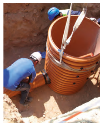
INSTALLATION DE TUBES AU CORPS DU REGARD
