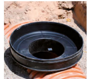
INSTALLATION DU CORPS AVEC BASE DE REGARD
