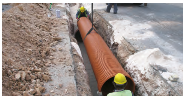
MANIPULATION SUR CHANTIER DU TUBE SANECOR®
