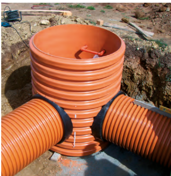
INSTALLATION DE REGARDS SUR COLLECTEURS AVEC CHANGEMENT DE DIRECTION
