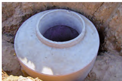
REGARDS EN MATÉRIAUX CONVENTIONNELLS (BÉTON ET BRIQUE) À DROITE, ANNEAUX PRÉFABRIQUÉS EN BÉTON
