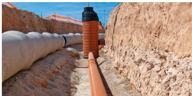
COLLECTEUR ET REGARDS SANECOR® POUR EAUX USÉES À CÔTÉ DE COLLECTEUR D'EAUX DE PLUIE EN BÉTON
