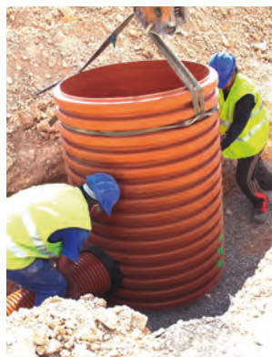
INSTALLATION DE TUBES AU CORPS DU REGARD
