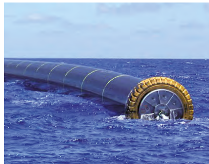
PE lisse (fréquent pour les émissaires sous-marins)
