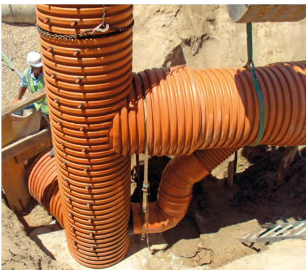
REGARD EN CASCADE AVEC LE SYSTÈME DE REGARD SANECOR® (À GAUCHE. TYPE MADRID)
