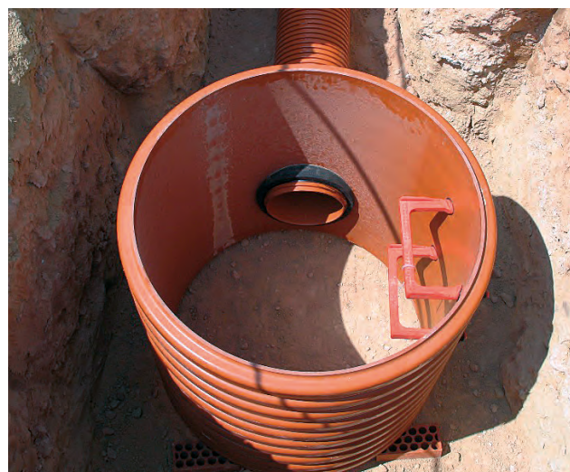
BÉTONNAGE DU FOND DU REGARD - 1ÈRE PHASE
