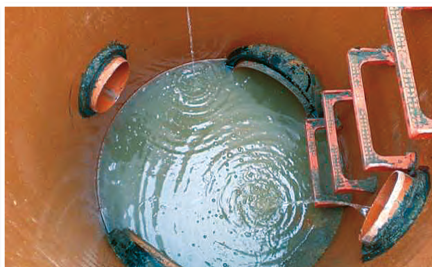
RÉALISATION DE MULTIPLES BRANCHEMENTS RÉALISÉS IN SITU
