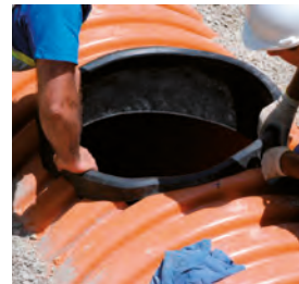
INSTALLATION DU CORPS AVEC BASE DE REGARD
