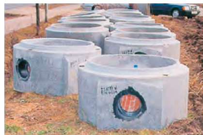
REGARDS EN MATÉRIAUX CONVENTIONNELLS (BÉTON ET BRIQUE) À DROITE, ANNEAUX PRÉFABRIQUÉS EN BÉTON
