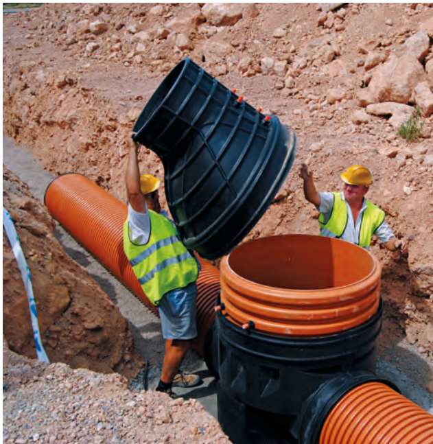
INSTALLATION DE PIÈCE EMBRANCHEMENT DE PASSAGE TOTAL
