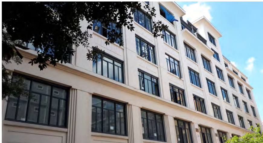
Réhabilitation et construction bâtiment Breteuil-Séguir, Paris 7ème (75)
